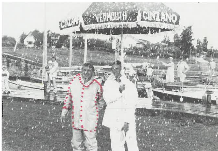
Väl regnskyddad eskaderledning vid Bergs slussar.
