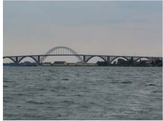
E4 bron utanför Vordingborg
