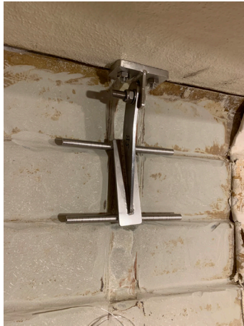
14. Provmonterat efter att bulhålet i nederdelen märkts upp och borrats.
